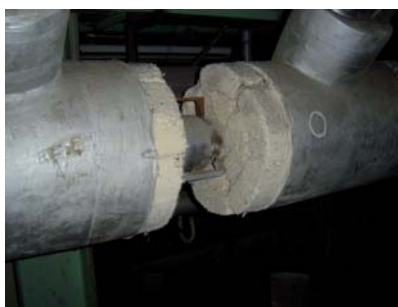
Figura A1.30 Detalle de calorifugado (coquilla)
