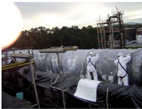
Figura A3.14 Colocación de los sacos de guantes para trabajar en una tubería
